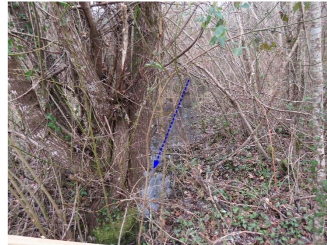
Connexion hydraulique supposée entre le bassin de rétention et le ruisseau de Boutouyre
