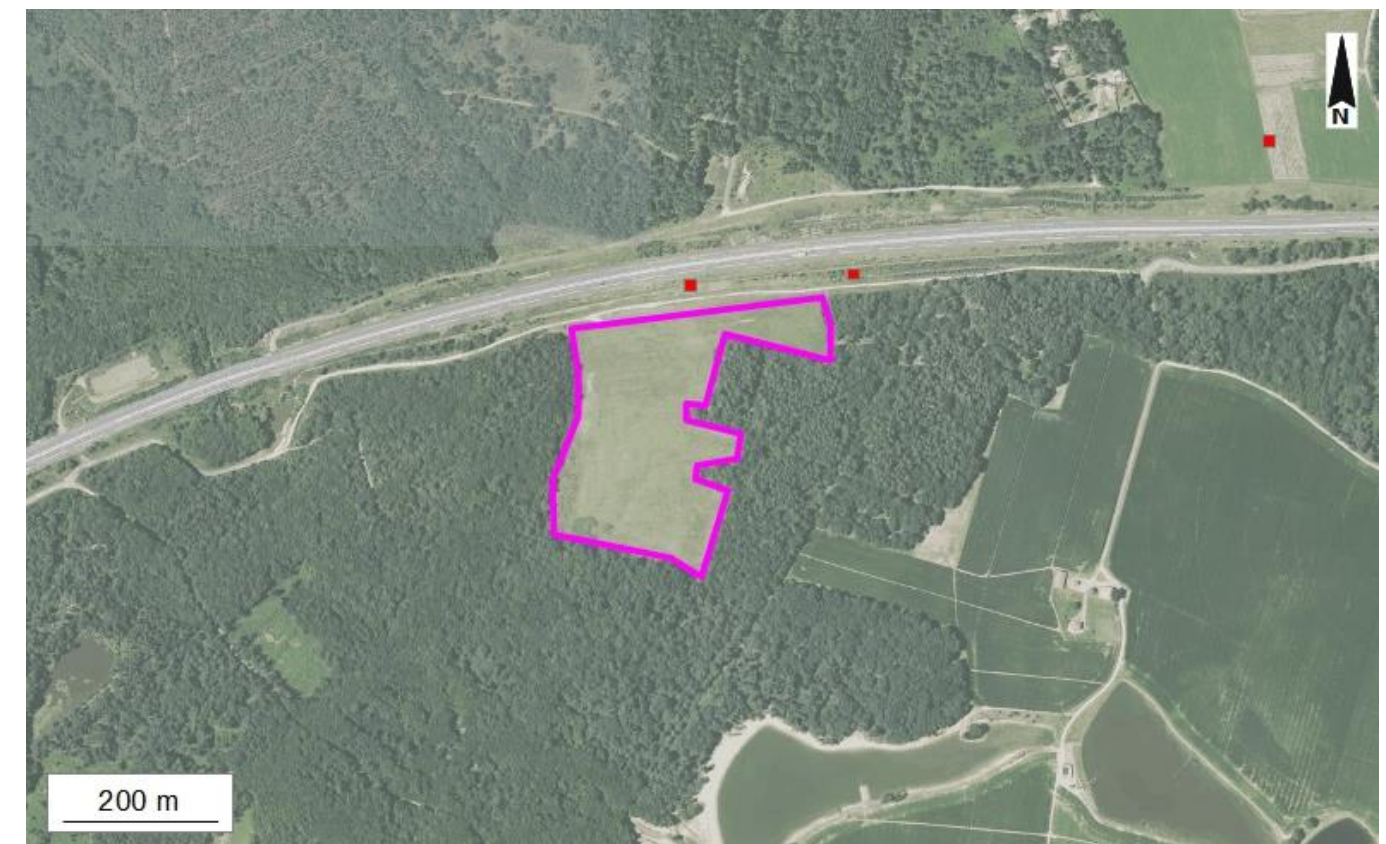
Glissements de terrains à proximité de la ZIP (source : infoterre)
