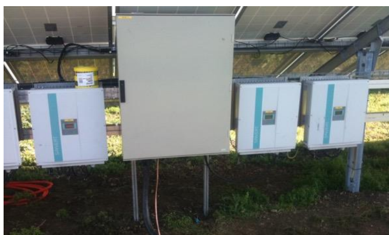
Exemple d'onduleurs décentralisés (source : KRONOS SOLAR)
